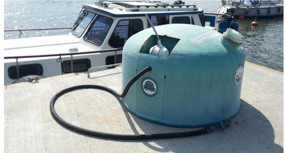
Kaunissaari (Pyhtää): käsikäyttöinen, laiturilla kiinteästi oleva tyhjennysasema säiliöllä
