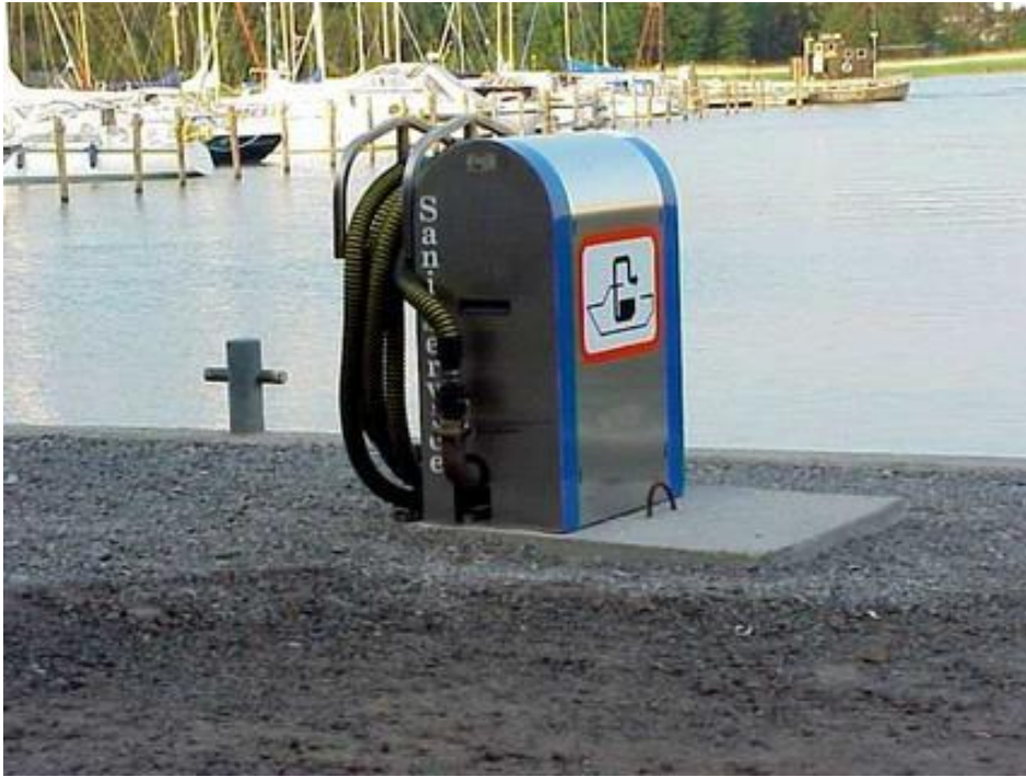
Kiinteä sähkötoiminen tyhjennyslaite. Käytössä mm. Loviisa Laivasilta ja Kotka Sapokka
